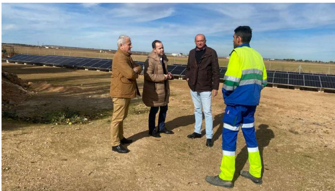
Instalación de placas solares en la estación depuradora de Herencia / Ayuntamiento de Herencia
